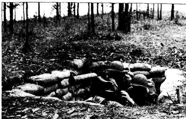
図34：土嚢で補強された立ったまま入れる砲座
